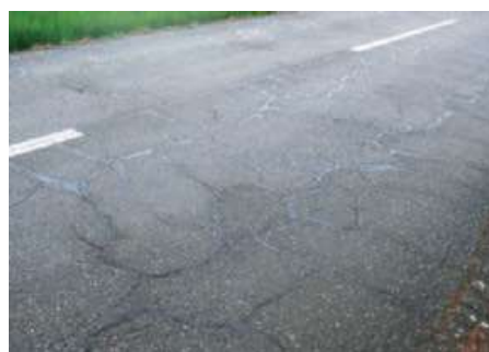
写真-2 特殊弾性ポリマー改質アスファルト適用箇所例
