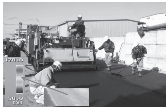
図-8 中温化ポリマー改質アスファルト混合物の施工の様子
